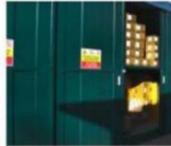
Penyimpanan LB3 kimia dalam masing-masing kompartemen yang berbeda
